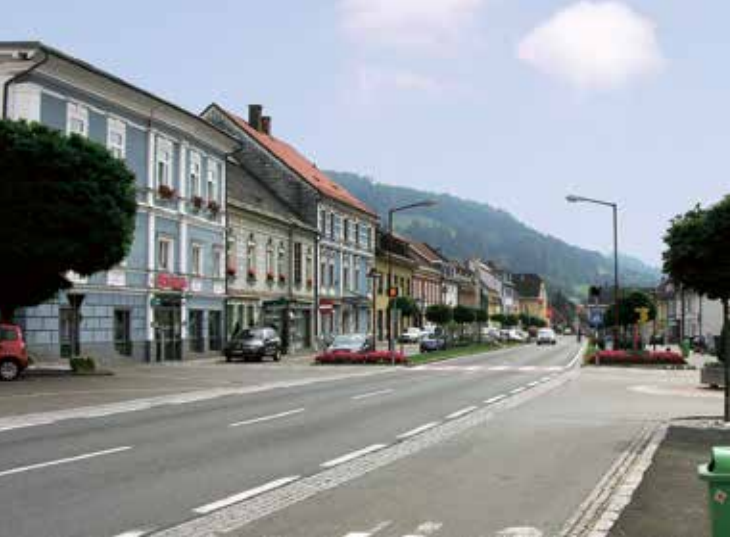
Der Hauptplatz von Bad St. Leonhard.
